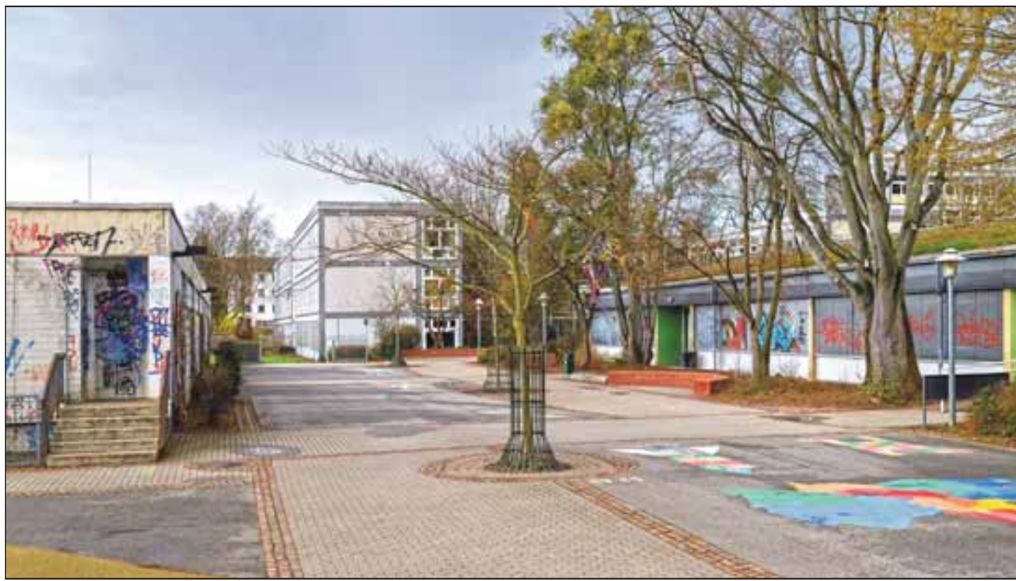
An Schultagen ist auf dem „Campus Mitte“ alles voller Schüler, an Wochenenden und abends ist es dagegen ziemlich leer. Deshalb scheinen sich hier Einbrecher sehr wohl zu fühlen. Das soll sich mit dem anstehenden Umbau ändern. Foto: Philipp Rothe
